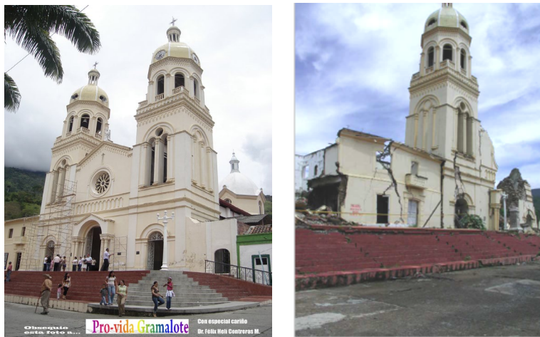
Figura 2. Destrucción de la población de Gramalote, Norte de Santander Colombia, antes y después del deslizamiento (Pedroza A., 2012)
